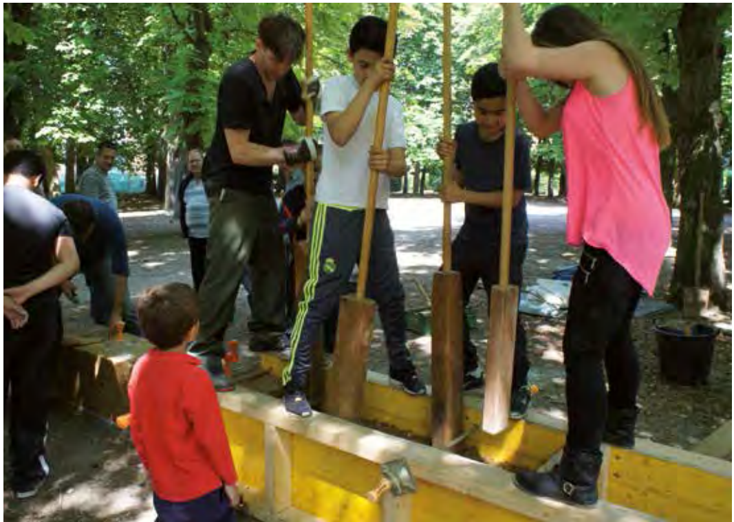
Chantier en cours avec les habitants de la cité / photo: Michèle Renard, juin 2015
